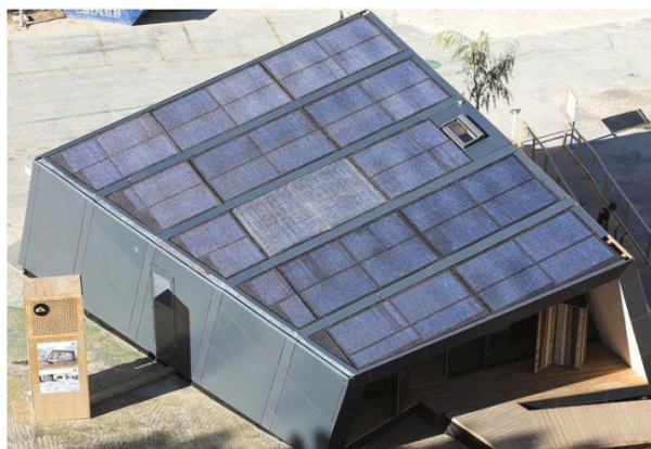
16-сурет - FOLD ғимаратының төбесіне орнатылған гибриді күн коллекторы
